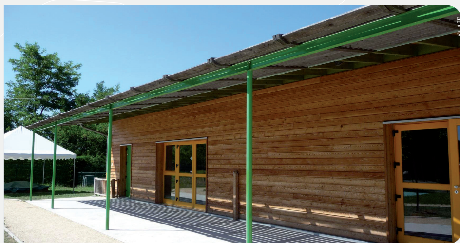
Espace petite enfance de Clérieux (26) - ARIES, architectes
