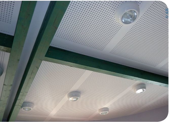
Espace petite enfance de Clérieux (26) - ARIES, architectes
